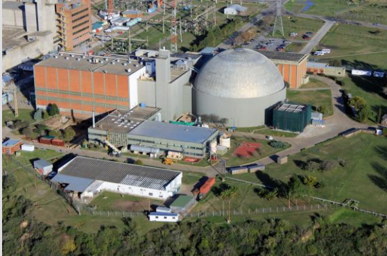
Courtesy of Nucleoeléctrica Argentina S.A.
