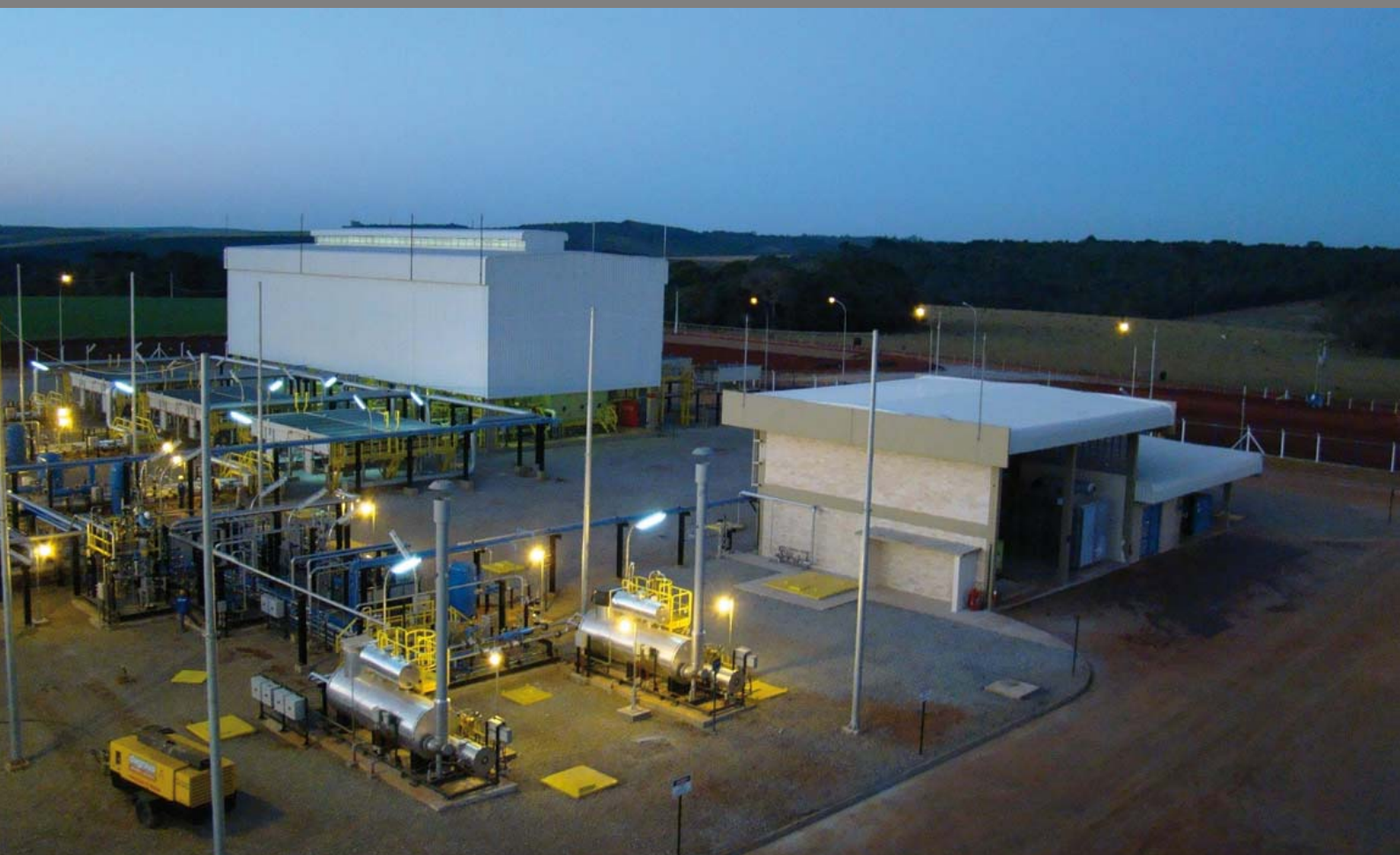
GAS COMPRESSION PLANT – CAPÃO BONITO - CAPÃO BONITO, BRAZIL – TBG (TRANSPORTADORA BRASILEIRA GASODUTO BOLIVIA-BRASIL)
